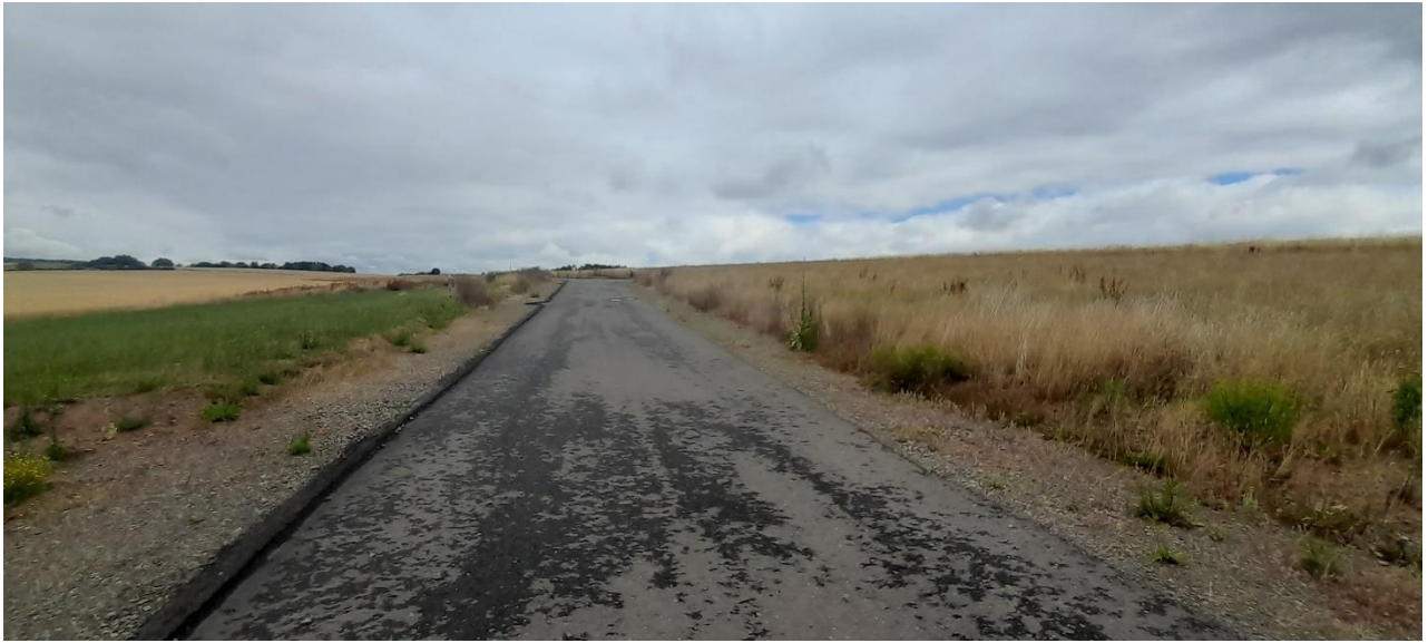
Abbildung 2 Blick auf das Plangebiet von Süden mit Blickrichtung nach Norden (eigene Aufnahme, Juli 2022)
