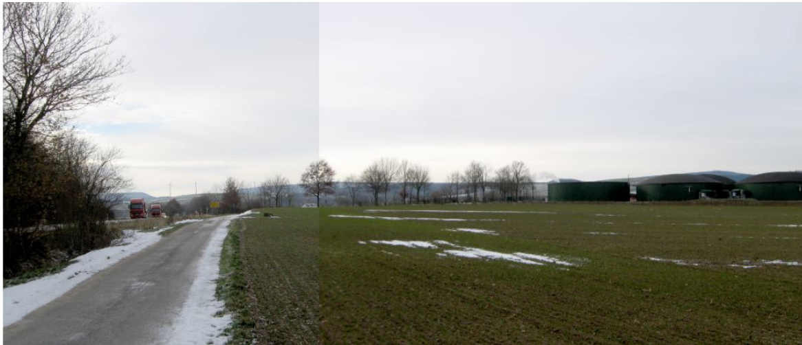
Blick vom parallel zur Bundesstraße 27 verlaufenden Wirtschaftsweg auf die Fläche, rechts im Bild die Biogasanlage Wollbrandshausen-Krebeck. Der Baumbestand in Bildmitte ist die straßenbegleitende Bepflanzung der Landesstraße 523, die dort in die Bundesstraße 27 einmündet.
